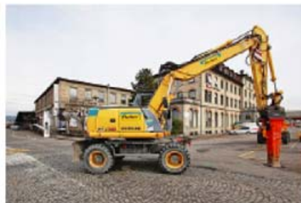
Arbeiten für eine Bauabschrankung um den Güterbahnhof. Foto: PD
